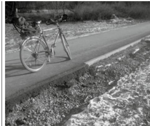
Nach dem Hochwasser im Januar 2011 wurde der gerade fertiggestellte Abschnitt des Ilmtal-Radweges zwischen Ehringsdorf und Taubach vom Hochwasser unterspült und erheblich in Mitleidenschaft gezogen. Dank an die Stadt Weimar, dass diese Schäden rasch und umfassend beseitigt wurden.
