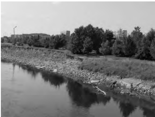
Zerstörter Elsterradweg in Gera-Zwötzen
