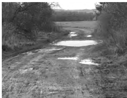
Die einzige vernünftige Route zum Nachbarort Werther sieht nach Regen so aus (zu den Ortsteilen Petersdorf, Herreden und Steinbrücken gibt es gar keinen Weg für Fußgänger und Radfahrer).
